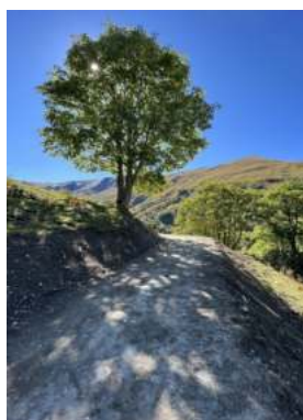
Amélioration du chemin de Pravel
